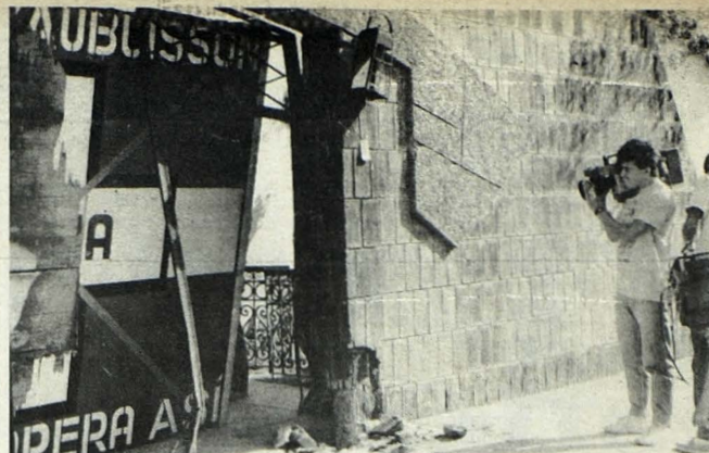
PORTON DESTRUIDO. (Santa Ana). El portón de metal de la casa de la diputada Gloria Salguero fue destruido al estallar una potente bomba el viernes último. No hubo daños personales.
