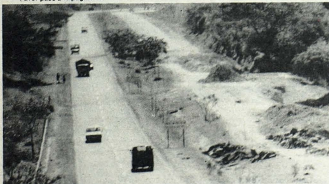
POR FIN SERÁ REPARADA. En respuesta a los reiterados señalamientos de EL DIARIO DE HOY, la autopista a Comalapa será reparada dentro de ocho meses, según el acuerdo firmado en Planificación por el gobierno y la AID. Los trabajos se iniciarán en julio.
