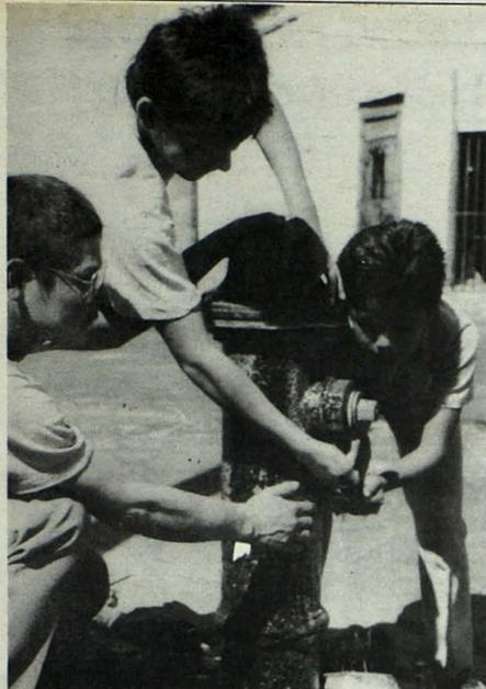
**DESPERDICIO DE AGUA.** A pesar de la millonaria campaña que está desplegando ANDA con "los consejos de la Gottita", muchos hidrantes están en malas condiciones causando un grave desperdicio de agua. El hidrante de la 1a. Avenida Sur y 12a. Calle Oriente tiene una fuga de agua desde hace más de un año, dijeron los vecinos.
