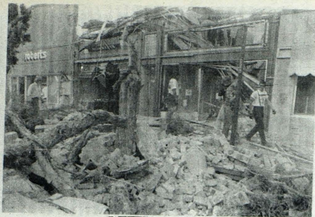
BUSQUEDA. Santa Cruz, Calif. Oct. 19 (AP). Residentes de Santa Cruz, caminan a través de los restos de edificios derrumbados en el centro comercial de la ciudad, luego del terremoto que sacudió esta localidad. El epicentro fue ubicado a 10 millas de Santa Cruz, 75 millas al sur de San Francisco.
