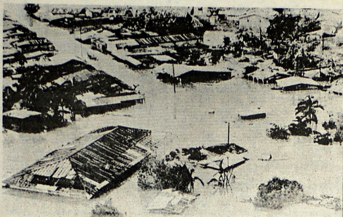
DESASTRE. Ciudad Rama, Nicaragua, Oct. 25 (AP-cablefoto). Los techos de las casas apenas sobresalen por
