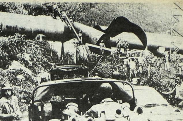
EXPLOSION. Lana, Italia, agosto 17 (AP-cablefoto). Bomberos trabajan en la reparación de una línea de agua de alta presión para la planta hidroeléctrica en las afueras de la Villa de Alto Adigio, cerca de Merano. Los daños fueron ocasionados por la explosión de una bomba colocada por terroristas de origen alemán.
