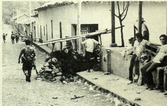
ZONA ATACADA. (Villa Victoria, Cabañas). Calle principal de Villa Victoria, ubicada a 96 kilómetros de San Salvador, atacada ayer por la madrugada por terroristas. Quemaron documentos y secuestraron a cinco defensas civiles.
