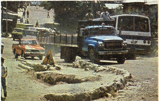
ZANJA AFECTA A AUTOMOVILISTAS. Una zanja que se encuentra en el Km. 4 de la Troncal del Norte afecta la circulación de los automovilistas que transitan por ese sector. La reparación del enorme bache se hace con lentitud.
