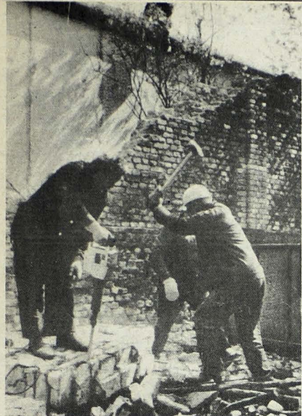
DERRIBAN VIEJO MURO. Berlín, abril 26. Obreros de Alemania Oriental demuelen el viejo muro de Berlín, luego que uno nuevo de hormigón armado fue construido para reemplazar al de ladrillos. (Cable-foto AP).
