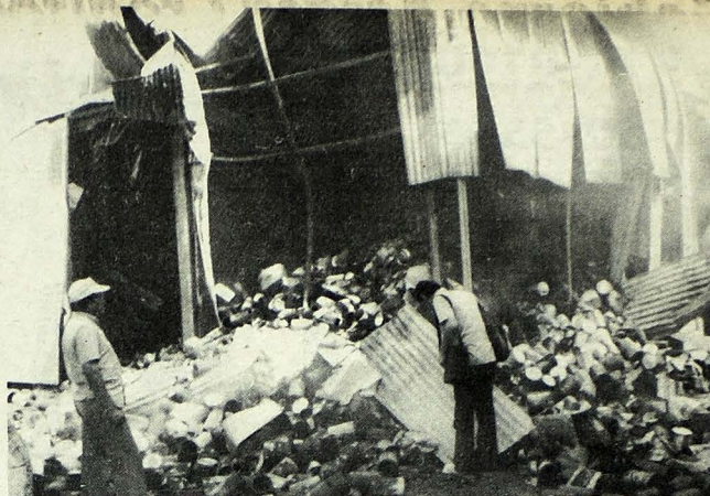
BODEGA INCENDIADA. (Usulután). Más de millón y medio de colones son las pérdidas provocadas por un incendio en una bodega del IRA, en esta ciudad. Empleados de la entidad descartan un cortocircuito, ya que en la bodega no existen instalaciones eléctricas.
