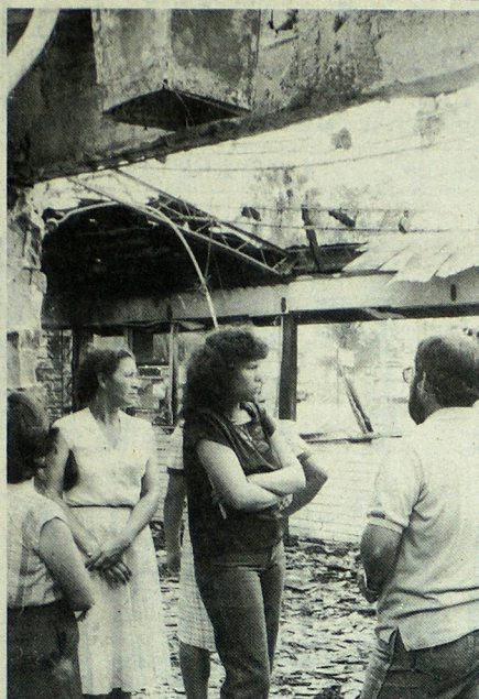
INCENDIO. Más 100 mil colones en pérdidas ocasionó al Sr. Luis Rosales el incendio que el jueves por la noche consumió el restaurante "Shung Shan", en la carretera a Santa Tecla. Los propietarios observan los daños del siniestro.
