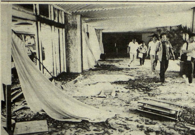
CONSTATAN DAÑOS. Manila, Oct. 14 (AP-cablefoto). Un grupo de periodistas recorre los pasillos del Hotel Manila, que hoy fue blanco de un ataque terrorista. Una potente bomba hizo explosión, dejando varios heridos y considerables daños materiales.
