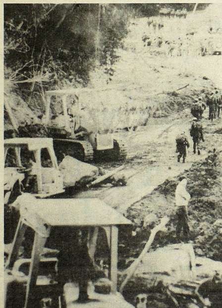
REMOCION. Maracay, Venezuela, Sept. 11 (AP-Cablefoto). Tractores de Instituciones gubernamentales participan en las labores de remoción de escombros, en el lugar donde perecieron centenares de personas. Muchas familias han resultado damnificadas por los derrumbes y desbordamientos de ríos.
