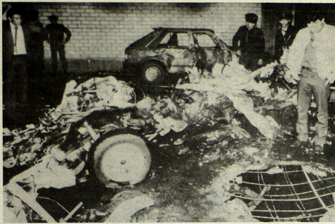
EXPLOSION. Lima, Sept. 3 (AP-cablefoto). Policías y detectives, observan parte de los daños causados anoche por la
