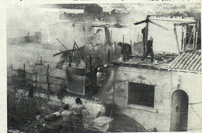
PERDIDAS EN INCENDIO. A varios miles de colones ascienden las pérdidas del incendio que consumió el merendero "El Corcel", Mesón Lima y taller de mecánica Cardoza, ubicados en la Calle Campos del B° San Jacinto. La presencia de los bomberos evitó que el fuego se propagara.
