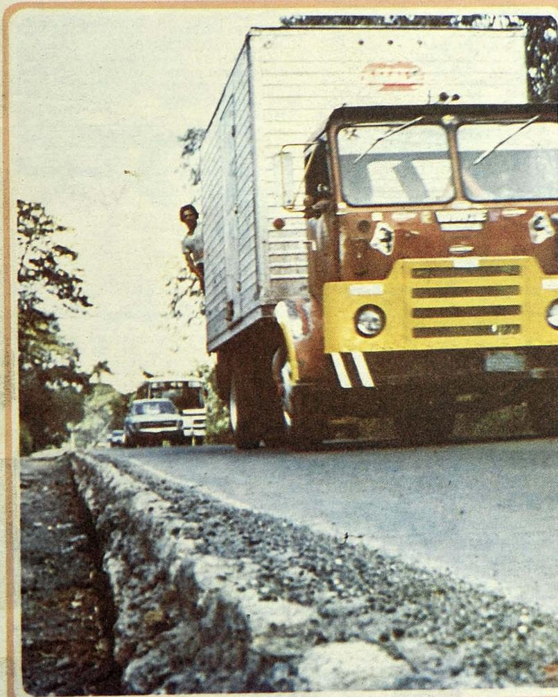
**PELIGROSA ZANJA.**— En un tramo de unos 300 metros, al lado de la vía que de Santa Tecla conduce a San Salvador, el MOP ha abierto una peligrosa zanja de casi un metro de profundidad que representa un grave peligro para los automovilistas, debido a la falta de señales. El hoyo es parte de los lentos trabajos de ampliación de dicha vía.
