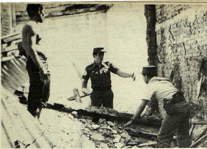
**ESCOMBROS.** Bomberos y un hombre particular inspeccionan los escombros de la casa que se desplomó, luego de rescatar a las víctimas. Debido a que la construcción es de bahareque, la intensa lluvia del jueves por la tarde debilitó las paredes.
