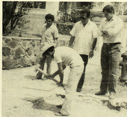
QUITAN BARRERAS. A fin de dar facilidades a los minusválidos para desplazarse por la ciudad, el Instituto de Previsión Social de la Fuerza Armada está construyendo rampas en el sector del parque Cuscatlán. El Ing. Roberto Antonio Alas supervisa los trabajos.
