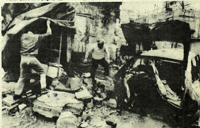
DAÑOS DE EXPLOSION. Líbano, marzo 26.- Libaneses inspeccionan los daños causados por la explosión de una bomba, colocada debajo de un vehículo, en el sector oeste musulmán de Beirut. El estallido quebró las vidrieras de las residencias contiguas al lugar del atentado. (AP).
