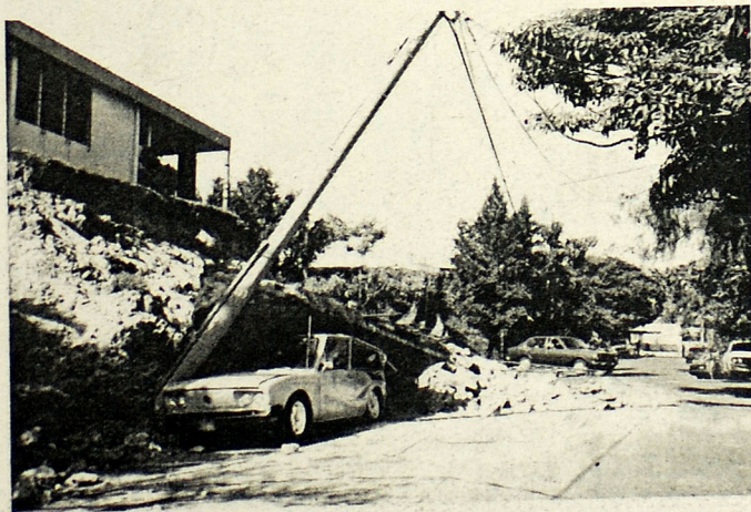
DERRUMBES. Un muro derrumbado en la Av. 4 de Mayo de la Colonia Buenos Aires.
