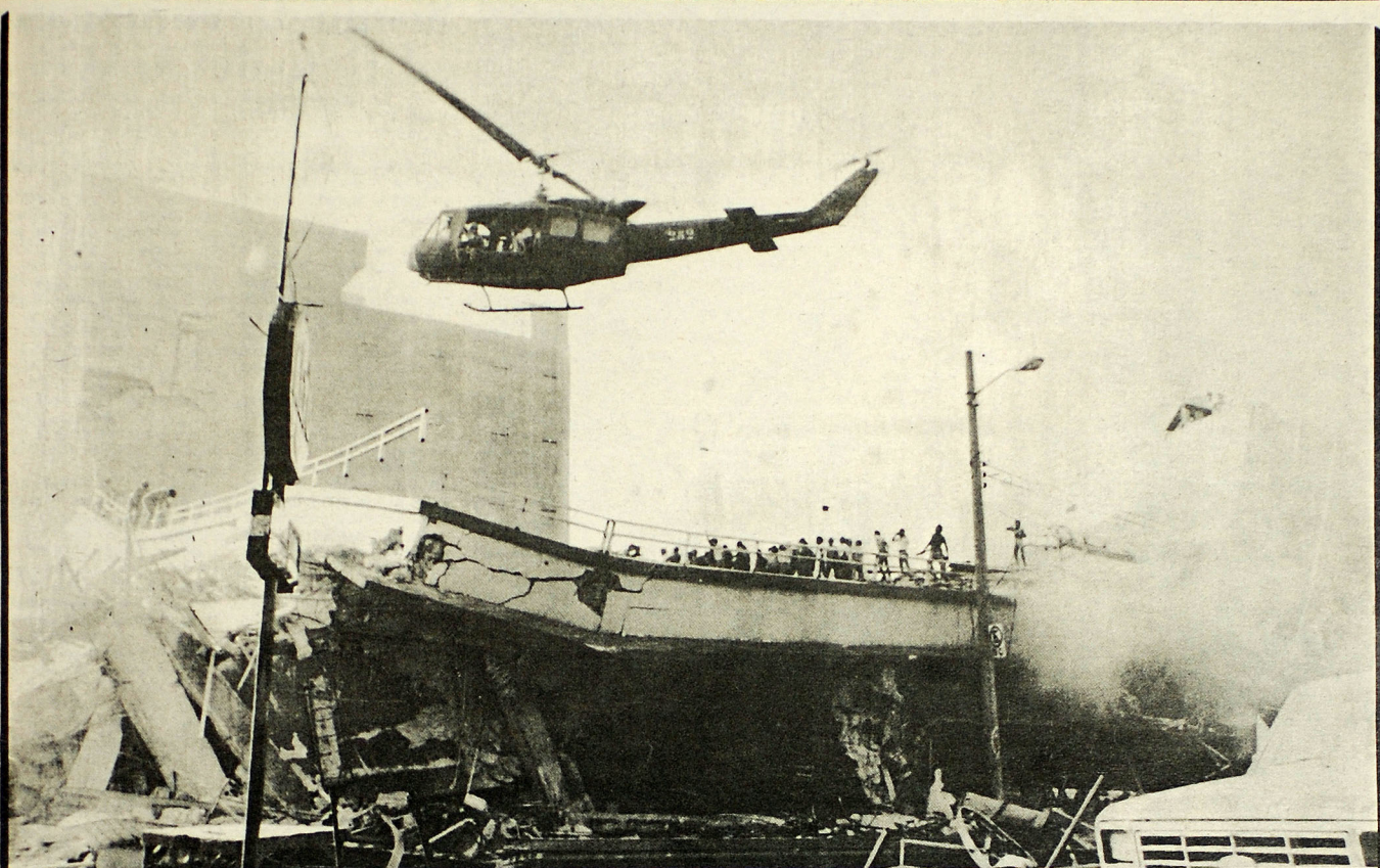
AUXILIO AEREO. Un helicóptero de la Fuerza Aérea Salvadoreña se acerca a los escombros del Edificio Rubén Darío, para entregar herramientas útiles en las labores de salvamento.
