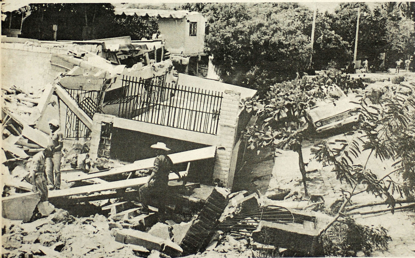
REMUEVEN ESCOMBROS. Habitantes del Reparto Santa Marta remueven los escombros de sus casas de habitación que fueron destruidas por el terremoto, el cual de acuerdo a los informes obtenidos tuvo su epicentro al Sur Oriente de San Salvador.
