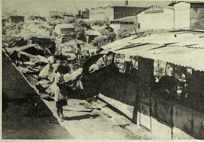
CUANTIOSAS PERDIDAS. Pérdidas estimadas en cerca de cien mil colones dejó el incendio de la noche del domingo en varios puestos del mercado Tinetti, ubicado en la 18a. Avenida Norte, barrio San Esteban, de esta capital.
