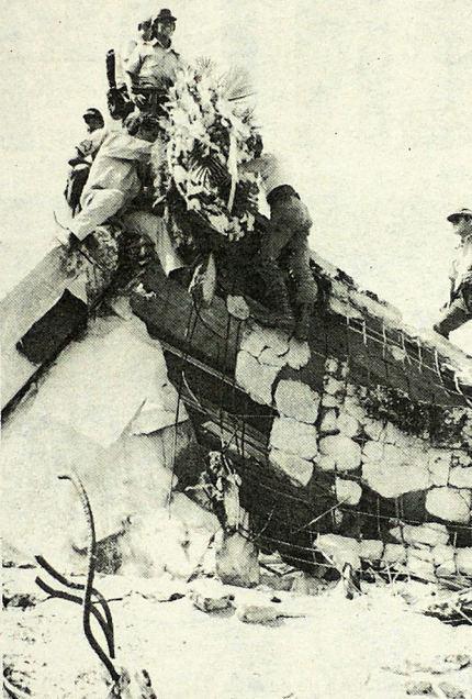
COLOCAN FLORES. — Cuerpos de seguridad y familiares de desaparecidos durante el terremoto del 10 de octubre, colocan flores en el otrora edificio Dario, en memoria de las personas que quedaron sepultadas allí.
