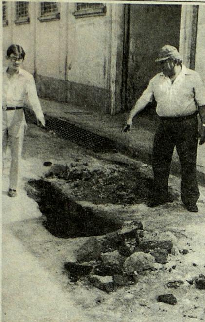
**HUNDIMIENTO.** Sobre la 9a. Calle Oriente, entre Av. España y 2a. Av. Norte, la ruptura de la cañería madre de agua que abastece a ese sector ha provocado un hundimiento en el pavimento. Los vecinos piden la pronta atención de ANDA y MOP.
