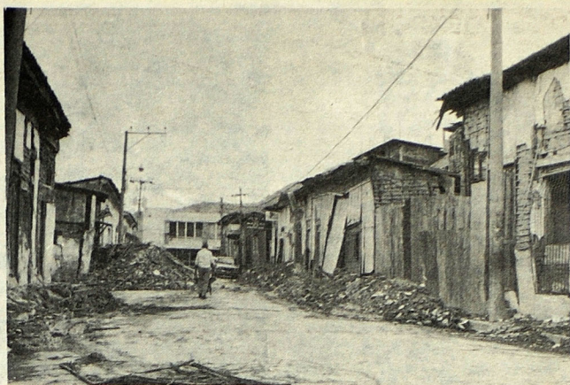
LA PLAZUELA Ayala, cerrada por los escombros, luce como una zona de desastre.
