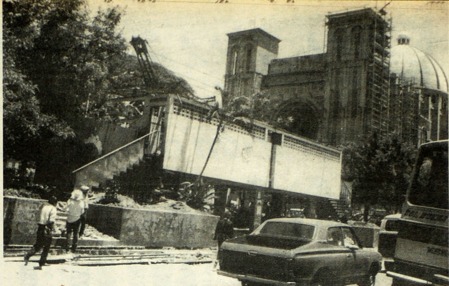
DESTRUYEN SERVICIOS SANITARIOS. Trabajadores de Obras Públicas demolieron ayer los servicios sanitarios que funcionaban en la plaza Barrios y que fueron construidos por una municipalidad democristiana. Lo anterior es parte de la llamada "renovación urbana".
