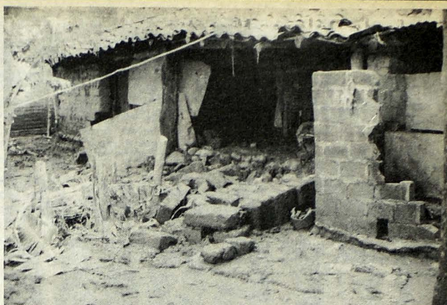
DESTRUCCION. — Esta es una de las viviendas de las muchas que arrastró el río La Bananera, dejando por lo menos 4 muertos y varios damnificados en La Unión. El río se desbordó por el copioso temporal que azotó al país la semana pasada.
