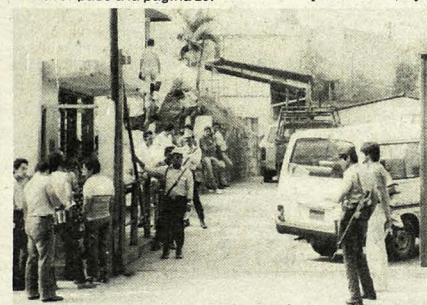
VIGILANCIA. Los cuerpos de seguridad mantienen estricta vigilancia en los alrededores de la Central ANTEL Roma, para evitar sabotajes en las instalaciones.
