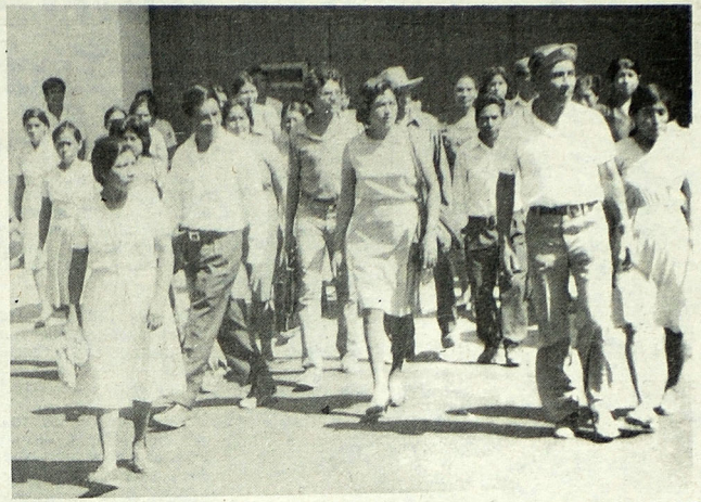
BUSCAN AYUDA PARA SUS HIJOS. Padres de familia de la escuela del cantón Quezalapa, de Panchimalco, piden ayuda inmediata para construir la escuela, ya que los recientes vientos huracanados, volaron el techo. Las paredes de adobe están a punto de derrumbarse.
