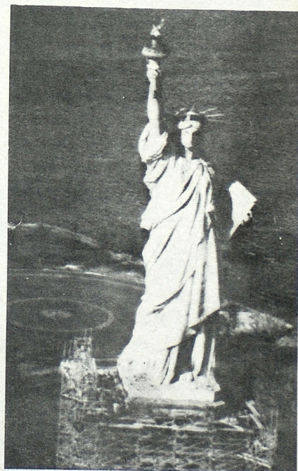
LIBRE DE ARMAZON. Nueva York, febrero 8. La estatua de la Libertad se erige libre de la amazona de acero, que aún cubre parte del pedestal, después de 20 meses de iniciados los trabajos de remodelación, los cuales deberán culminar antes del 4 de julio. (AP).
