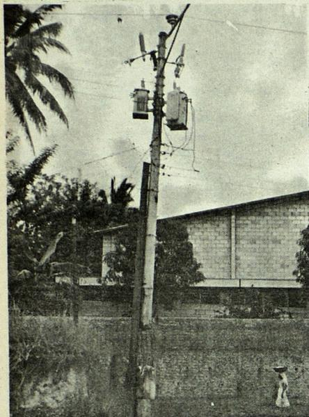
**RESULTADOS.** Así lucen muchos postes sostenedores del tendido de alumbrado eléctrico y transformadores, ubicados a orillas de la Carretera Troncal del Norte y otras carreteras importantes del país, debido a los atentados dinamiteros. CAESS acude a su reparación reforzándolos con postes de madera.
