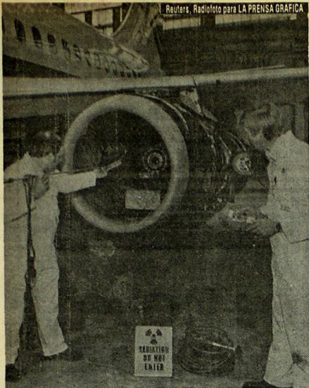
**MINUCIOSA INSPECCION.** Londres, Agosto 29 (Reuters). Mecánicos de la British Airways inspeccionan minuciosamente, las cámaras de combustión del motor Pratt y Whitney JT8D, en el Aeropuerto de Heathrow. Los exámenes han sido ordenados por el gobierno a raíz de una reciente tragedia aérea en Manchester.
