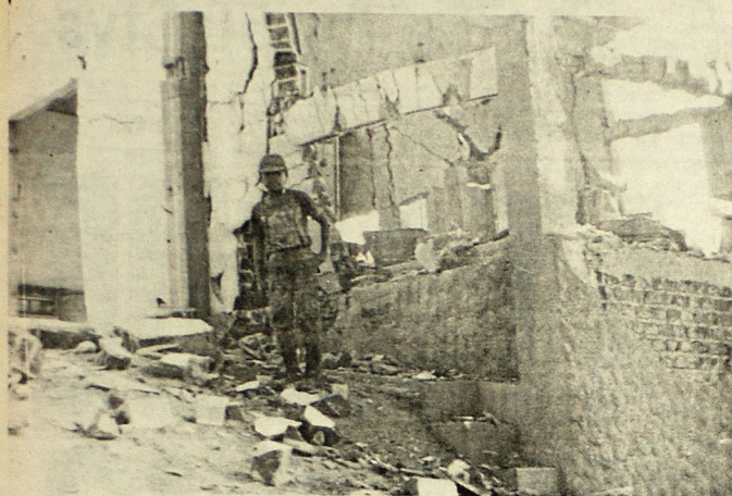
DESTRUCCION. Los daños materiales causados por los terroristas en su intento de dinamitar las instalaciones de telecomunicaciones nacionales e internacionales, ubicadas en El Picacho del volcán de San Salvador, el pasado fin de semana en
