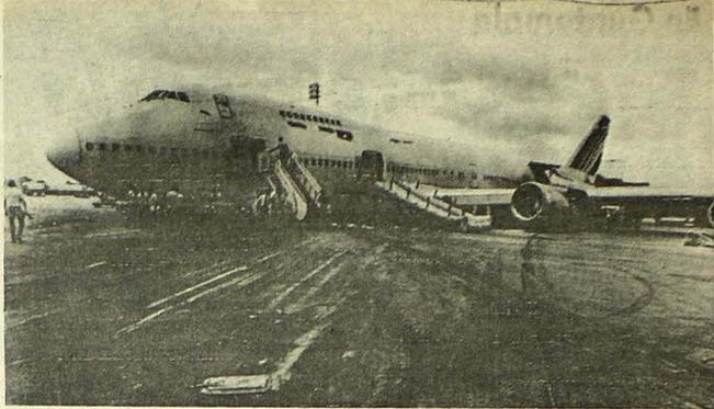
SE ACCIDENTA AVION. Río de Janeiro, diciembre 2. Boeing 747 Jumbo Jet, de la compañía Air France, que patinó en la pista cuando el tren de aterrizaje se rompió, poco después de aterrizar en Río de Janeiro. En la pista se observan las marcas dejadas por el avión y las ruedas desprendidas junto a la nave. No hubo muertos ni heridos. (Reuter).
