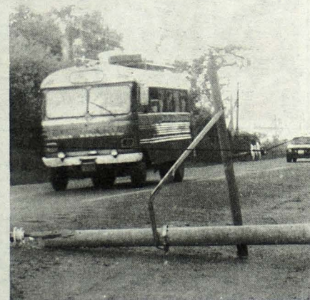
DERRIBAN POSTE. Terroristas dejaron a oscuras San Martín, al dinamitar un poste de alumbrado en el kilómetro 13 y medio, carretera a Oriente del país.
