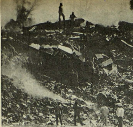
SIGUE DEMOLICION. Ciudad de México, octubre 27.— Trabajadores lanzanagua y productos químicos a los restos de un edificio, en la Colonia Roma, después de que expertos en demolición usaron dinamita para botar la estructura dañada por los sismos del mes pasado. (Reuter).
