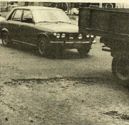
BACHES. Obras Públicas dijo que durante la estación seca sería reparado el pavimento de las vías del país. En la 49ª Avenida Sur, entre Calle El Progreso y 12ª Calle Poniente, hay baches. Al igual que ésta en otras vías se observa la misma situación.
