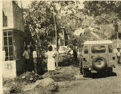
SIETE EDIFICIOS EN PELIGRO. Vecinos del Centro Urbano Amapetec se quejan del peligro a que están expuestos, por los desprendimientos de rocas del cerro de San Jacinto. Miembros del Comité de Emergencia del IVU y Fondo Social para la Vivienda, estuvieron a inspeccionar y buscar solución al problema. En primer plano algunas rocas que se han desprendido.
