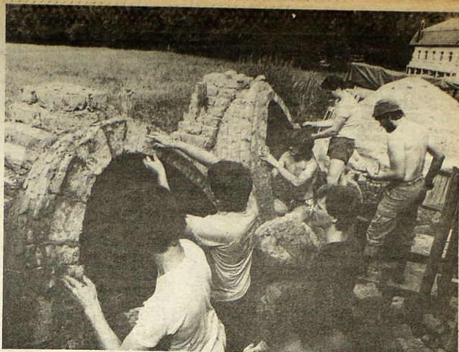
VENTAJAS DEL BARRO. Bonn, abril (INP). Grupo de albañiles alemanes construyen tuberías de desagüe, durante un experimento en que hacen diversas
