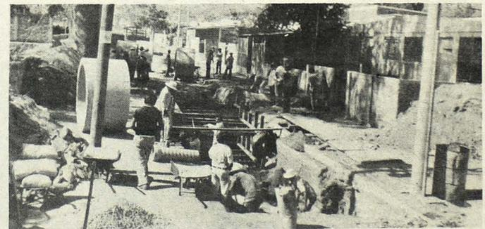
**COLECTOR EN CONSTRUCCION.** Sobre la Calle Principal de la colonia "El Guaje", en inmediaciones del cerro San Jacinto, jurisdicción de Soyapango, la Dirección de Urbanismo y Arquitectura (DUA), agiliza los trabajos de un gigantesco colector de aguas lluvias, con el cual se evitarán definitivamente las inundaciones por ese sector populoso. Se proyecta concluir la obra antes del invierno.
