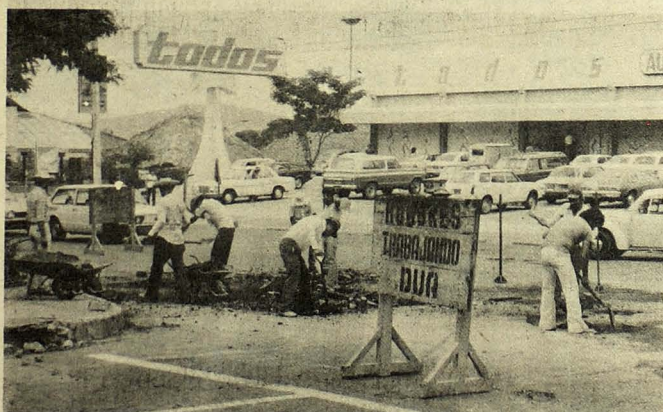
REPARACION. — DUA inició trabajos de reparación en algunas vías de la capital, atendiendo el clamor del público que ya no soporta los baches en las calles de San Salvador y colonias. Una de las más dañadas es la 29ª Calle Poniente. Trabajadores de DUA comienzan la reparación en el Paseo General Escalón y 79ª Avenida Norte.
