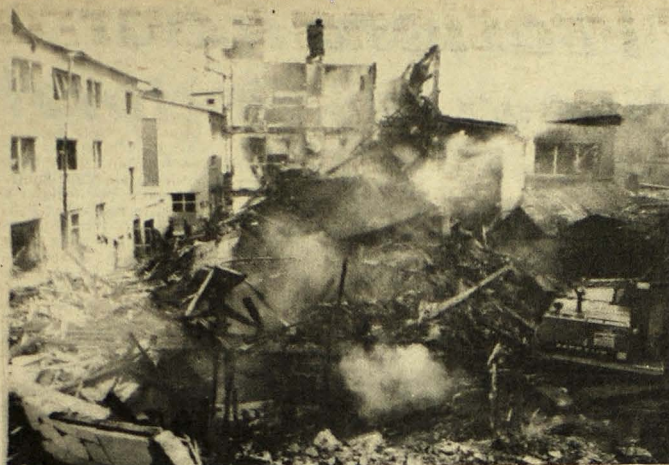
EXPLOSION DE GAS. Esslingen, Alemania Occidental, julio 3 (AP).—Una explosión provocada por un escape de gas y el incendio posterior, destruyeron este colegio técnico en Esslingen. Hubo 15 heridos y $10 millones de pérdidas.
