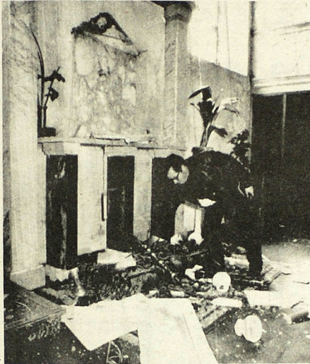
DAÑOS POR TERREMOTO. Pescara, Italia, mayo 8. — Un sacerdote inspecciona los daños en el altar de una iglesia que se desplomó parcialmente aquí, como consecuencia del terremoto que afectó hoy a Italia.
