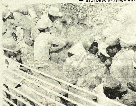
RESCATAN VICTIMAS. Brigadas de rescate buscan víctimas entre los restos de un viejo edificio de viviendas que se derrumbó hoy. Hubo 21 muertos. La oficina de urbanismo había advertido a los vecinos que el inmueble debía ser demolido.
