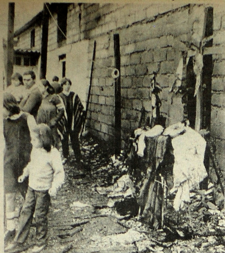
IGLESIA INCENDIADA. Santiago, Chile, mayo 3.— Vecinos observan los daños dentro de lo que fué la Iglesia Parroquial de San Martín de Porres, en la capital chilena, la cual fue incendiada por bombas terroristas. Es el cuarto templo católico destruido este año en Chile.
