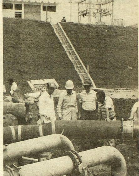
**AVANZAN OBRAS.** Funcionarios de ANDA inspeccionan las obras de montaje del sistema de bombeo en las captaciones de San Lorenzo, Proyecto Zona Norte, entre Sitio del Niño y Quezaltepeque. Arriba, subestación eléctrica. Abajo, sistema de captación del manantial y sección parcial de los equipos de bombeo.
