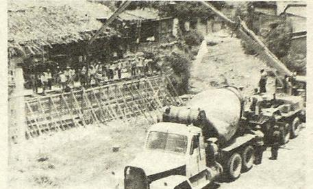
**MURO DE CONTENCIÓN.** Setenta y seis trabajadores de la DUA, construyen un muro de contención a la orilla del río conocido como Arenal de Montserrat y que pasa por la Calle Francisco Menéndez, para evitar que con la entrada del presente invierno pueda seguir socavando la zona, exponiendo a graves peligros a numerosas familias que residen frente a las instalaciones del Cuerpo de Bomberos y Marina Nacional.
