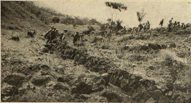
COMBATESE EROSION. Ocho kilómetros de muros piedras paralelos, han levantado en 50 manzanas de superficie donde se siembran maíz y frijol, beneficiarios del
