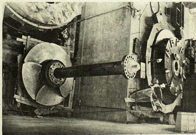
**POTENCIA PARA EL FUTURO.**— Parte superior de la foto muestra el rotor de la segunda unidad generadora que se prepara para el montaje, en la casa de máquinas de la Central Hidroeléctrica de San Lorenzo. La parte inferior, muestra el eje vertical de la turbina, con los álabes cerrados. Los equipos similares de la primera unidad ya instalada, van a prueba en julio próximo, informa CEL.
