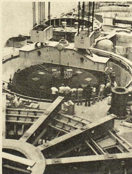
**MONTAJE ELECTROMECANICO.**— El rotor de la primera unidad generadora de la central de San Lorenzo que construye la CEL en el Río Lempa, fue colocado en su sitio, suspendido de potente grúa. La foto capta el exito final de la maniobra de montaje. San Lorenzo tendrá una capacidad generadora de 180.000 kilovatios. La primera unidad se pondrá en marcha a mediados del presente año.
