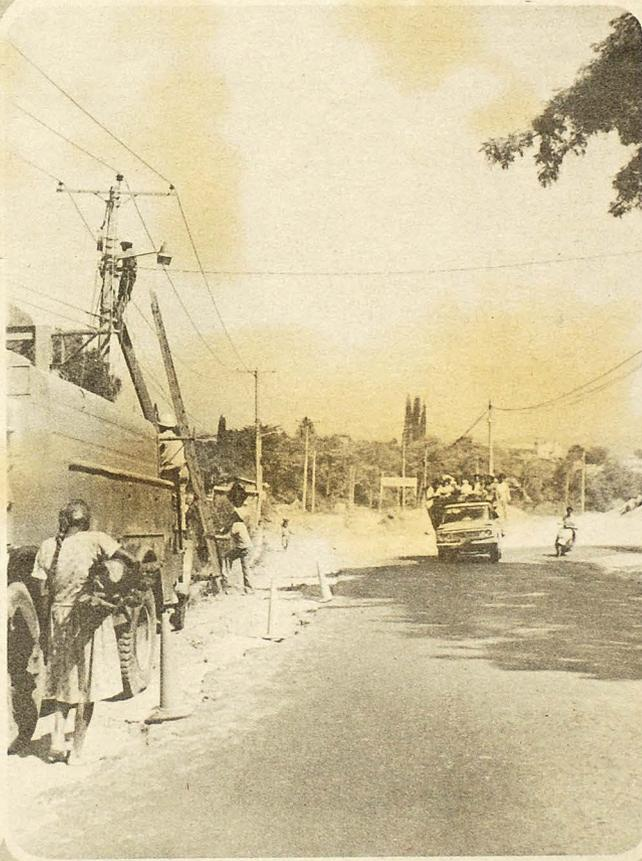
**INTENSA LABOR.** Cuadrillas de trabajadores de CAESS, y de otras instituciones de servicio público llevan a cabo una intensa labor de relocalización de los diferentes ductos y conexiones eléctricas donde se construirá un moderno "Trébol" en la intersección de la Autopista Aeropuerto El Salvador y carretera Planes de Renderos. Los trabajos están avanzados, se informó.
